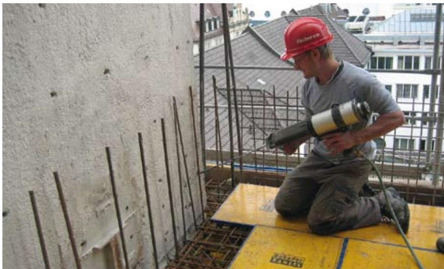
Bis zu 2 m tiefe Löcher sind für nachträgliche Bewehrungsanschlüsse möglich. Nach der Aushärtezeit können die Bewehrungsstäbe wie normale, einbetonierte Stäbe behandelt und belastet werden.
