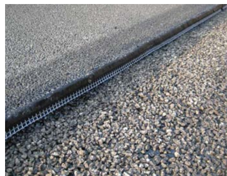
Das TOK-Band Drain SK von DENSO ist im unteren Bereich wasserdurchlässig.
