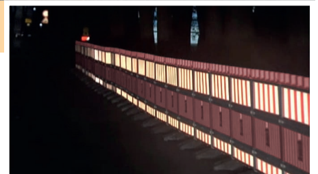
Sicherheit geht vor: Die EH-Absturzsicherung „Reflex“ ist auch bei Dunkelheit gut sichtbar.
