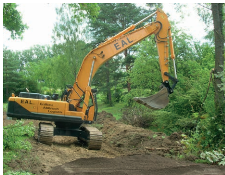
Der Kettenbagger R320NLC-9 von Hyundai leistet bei der EAL Erdbau Abbruch & Logistik GmbH, Vogtsburg, gute Dienste.
