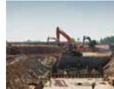
Tief- und Straßenbau
