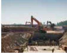
Tief- und Straßenbau
